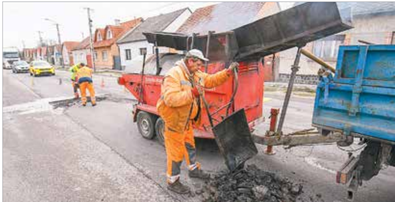
A szakemberek ilyenkor, amíg a téli időjárás tart, leginkább zsákos aszfaltot használnak, de ha plusz öt fok fölé megy a hőmérséklet, akkor már a képen látható aszfalt-újrahasznosító géppel is tudnak dolgozni
