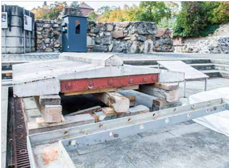
A fedlap szétszedésekor kiderült, hogy elkorhadtak a párnafák, ezeket is cserélik
