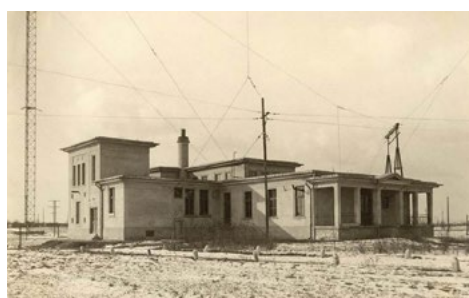
Rádióállomás épülete 1924. Forrás: erdekesfehevar.hu
