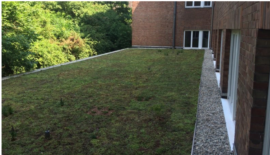
Előkép: Egy budapesti közintézmény épületén megvalósult extenzív zöldtető (fotó: Dimitrievits Dóra, Budapest, 2017)
