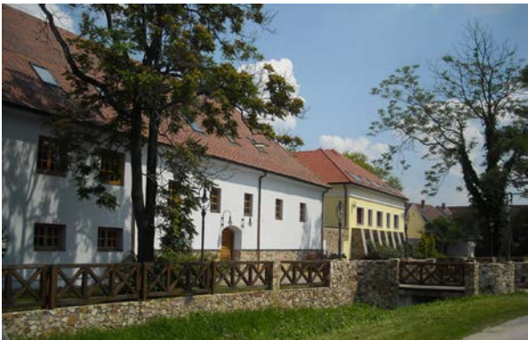
SÖRHÁZ TÉR 1. törzsszám 9825 SÖRHÁZ ÉS VOLT LAKÓÉPÜLET védelmi (bírság) kategória: III. hrsz: 4255/7 azonosító: 15828
