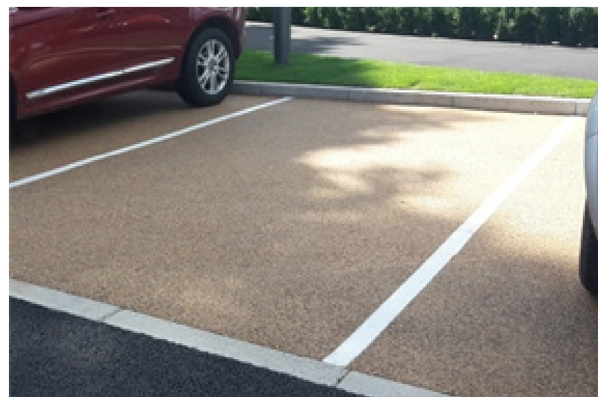
Előkép: stabilizált kavics/zúzottkő burkolat
