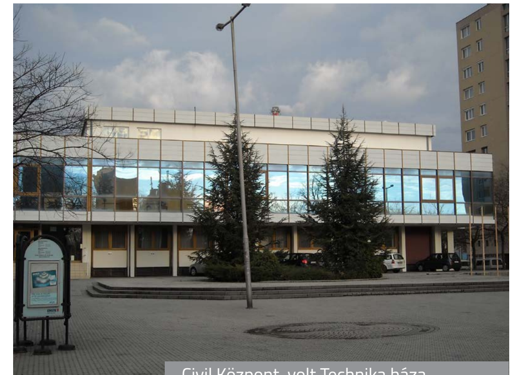
Civil Központ, volt Technika háza
