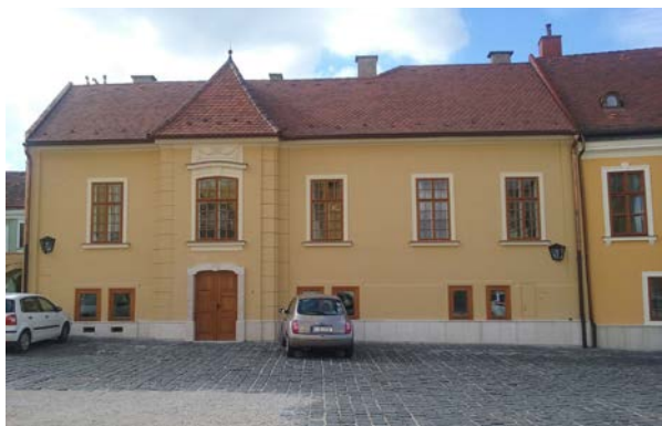
ARANY JÁNOS UTCA 5., (MEGYEHÁZ UTCA 6.) törzsszám 1477 LAKÓHÁZ (BALASSA-HÁZ) védelmi (bírság) kategória: III. hrsz: 309 azonosító: 3810 A XVIII. szd. elején üres telek, majd az északi részén épült egy földszintes ház. A kora barokk lakóházat Miskei István alispán, majd Posgay Ferenc főjegyző építtette. 1784-ig Balassa István kanonoké, majd 1848-ig a káptalané. Guitmann József ügyvéd 1857 után bővítette. Arany J. utcai homlokzatát 1938-ban Kotsis Iván alakította mai formájára. GPS koordináták: 47,190343°; 18,409547° műemléki környezet (hrsz): azonosító: Ny
