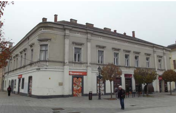
MÁTYÁS KIRÁLY KÖRÚT 23. LAKÓHÁZ védelmi (bírság) kategória: III.. törzsszám 8784 hrsz: 56 azonosító: 3860 XVIII. szd. végi ház felhasználásával épült 1860 körül romantikus stílusban. 1863-tól a Nádor utca végi épületben működött a Karl-család fűszerkereskedése. Trapéz alaprajzú, belső udvaros épület lekerekített sarkokkal. A Marosi A. utcában 5 kerek kerámiatárcsa: Karl József és fia, Székesfehérvár, 1863 felirattal, közepén a város címerével. GPS koordináták: 47,195389°; 18,409210° műemléki környezet (hrsz): azonosító: Ny
