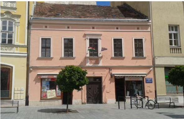
FŐ UTCA 9. törzsszám 10833 Közép- és török kori épületmaradványok felhasználásával Khaut Barbély Ferenc megyei és városi seborvos 1826 előtt a déli szárnyal bővítette. Klasszicista homlokzatát még a XIX. szd-ban magasították. Romantikus átalakítása a lépcsőház és az északi szárny építésével 1857 után Stéger (Jagsitz) Viktor cukrászmester birtoklása idején történt. LAKÓHÁZ védelmi (bírság) kategória: II. hrsz: 93 azonosító: 3830 GPS koordináták: 47,193313°; 18,409257° műemléki környezet (hrsz): azonosító: 21967 92, 94, 136, 265, 266
